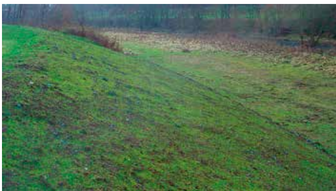
Abbildung 6.3.3 Ca. vier Wochen nach der Fertigstellung hat die Raseneinsaat gekeimt.
