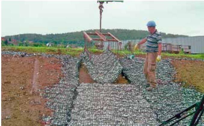
Abbildung 6.3.1 Sicherung der Böschung eines Umflutkanals (Steinmatratzen).
