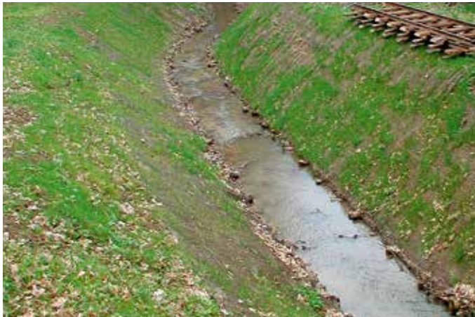
Abbildung 4.2.2 Böschungsfußsicherung und flächiger Erosionsschutz bei starker Hochwasserbelas- tung (Buschfascine und Erosionsschutzmatte).
