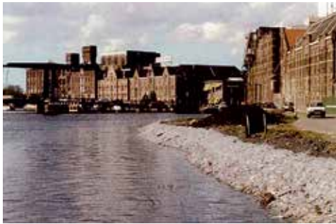
Abbildungen 4.4.3 und 4.4.4: Röhricht-Gabionen an der Maas in den Niederlanden
