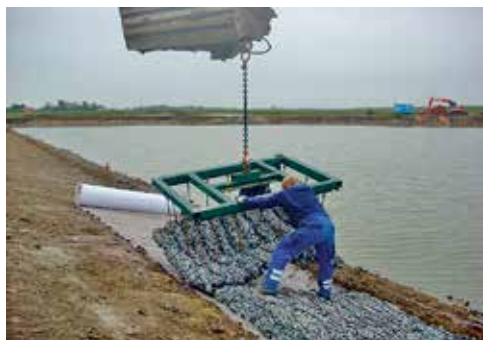
Abbildung 5.4.3.7: Einbau der Steinmatratzen auf der profilierten Uferböschung.
