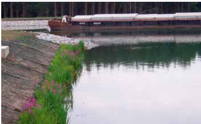
Abbildung 4.4.2.3 Röhricht-Gabionen an einer Kanalaufweitung.
