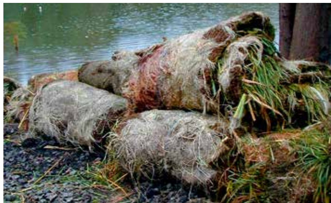
Abbildung 5.2.3.1 Röhrichtmatten werden aufgerollt angeliefert und zwischengelagert. Die Entwicklung von Wurzeln und Ausläufern ist gut zu erkennen.
