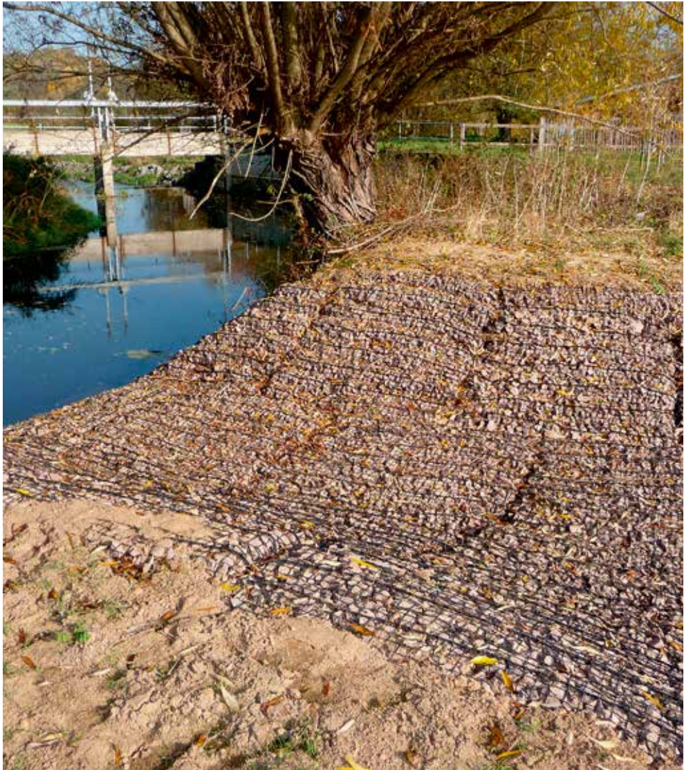
Abbildung 6.4.1 Auslauf eines Hochwasserrückhaltebeckens, (Steinmatratzen).
