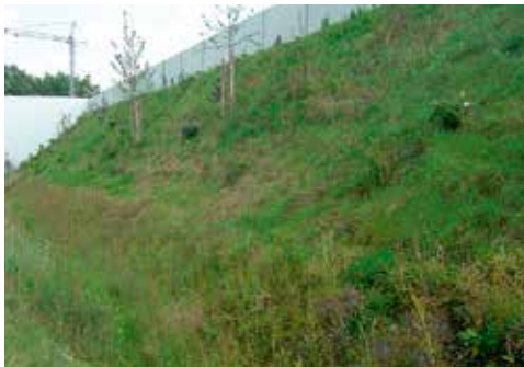
Abbildung 6.1.2.2: Nach dem Abrutschen des Oberbodens wird die Böschung wieder gesichert (Steinmatratzen und Kokoswalzen).
