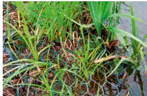
Abbildungen 4.4.2.1 und 4.4.2.2: Röhricht-Gabionen erlauben eine standortgerechte Begrünung auch unter hydraulischer Belastung.
