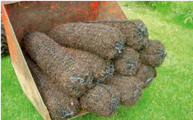
Abbildung 4.3.10 Transport von Xylitwalzen auf der Baustelle.
