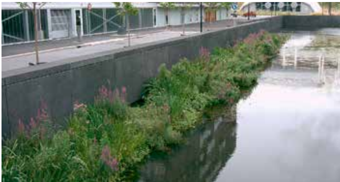
Abbildung 7.2.7 zeigt eine Röhrchinsel auf einem Kanal in Amsterdam. Sie kaschiert die Ufermauer und wertet den innerstädtische Bereich optisch wie ökologisch auf.
