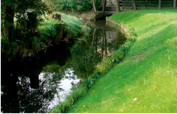
Abbildung 4.0.2 Derselbe Bach etwas weiter oberhalb ca. 6 Wochen nach der Baumaßnahme (Röhrichtwalzen und Kokosgewebe).
