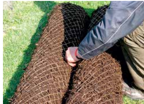
Abbildung 3.7.2: Xylitwalzen haben Standardlängen von 2,00 m und einen Durchmesser von 25 cm. Eine Xylitwalze wiegt etwa 40 kg.
