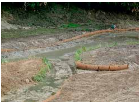
Abbildung 4.0.4: Zur Neugestaltung eines Bachlaufes werden die Ufer gesichert (Röhricht- und Kokoswalzen).
