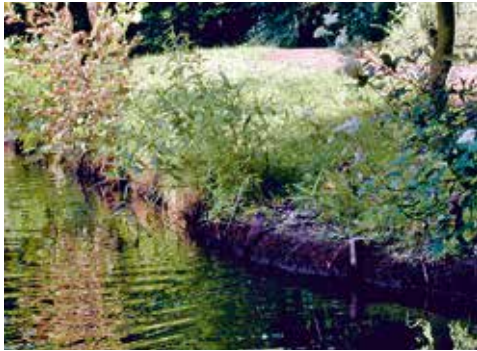
Abbildung 5.2.5.1: Xylitwalze 3 Jahre nach dem Einbau. Es entwickelt sich langsam eine Spontanvegetation.
