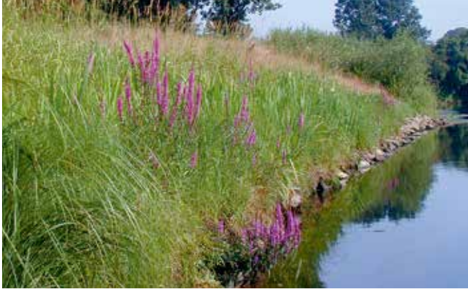
Abbildung 4.2.7 Flächige Sicherung dieser Böschung ca. zwei Jahre später (Röhrichtmatten und Kokosgewebe).
