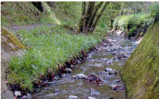
Abbildung 4.3.11 Anschließend an ein Wasserbaupflaster erfolgte eine ingenieurbologische Sicherung (Xylitwalze und Röhrichtmatte).
