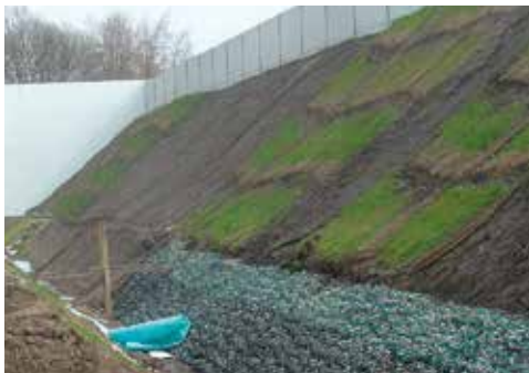
Abbildung 6.1.2.2: Nach dem Abrutschen des Oberbodens wird die Böschung wieder gesichert (Steinmatratzen und Kokoswalzen).
