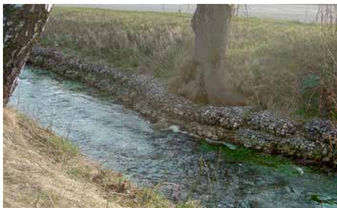
Abbildung 4.3.22 Anpassung an die vorhandene Uferlinie (Steinwalzen, doppellagig).
