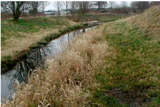
Abbildung 4.1.3.3 Kokosgewebe und Einzel- pflanzen als Ufersicherung und Uferbegrünung.
