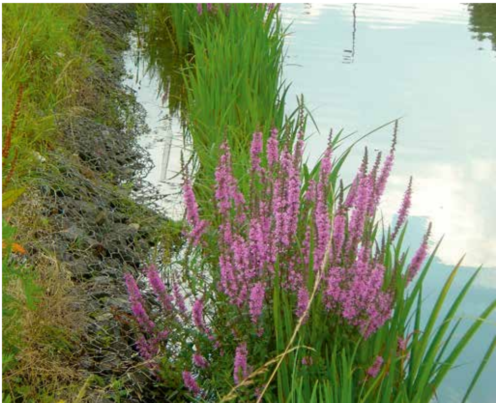
Abbildung 4.4.1 Röhricht-Gabionen an einem nordfranzösischen Kanal.
