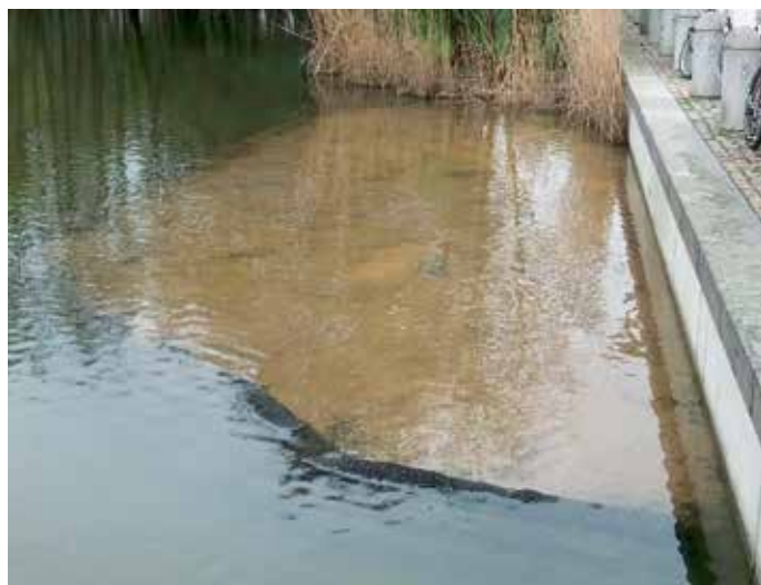
Abbildung 5.3.4.2 Neu angelegte submerse Berme.
