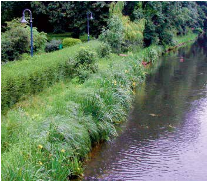
Abbildung 4.3.2 Böschungssicherung mit Kokoswalzen und Röhrichtmatten.
