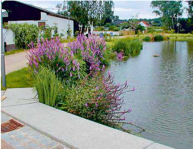
Abbildung 5.0.3 Ufergestaltung an einem innerörtlichen Teich mit Röhrichtmatten und Röhrichtwalzen.
