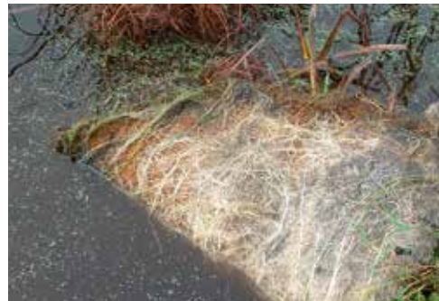
Abbildung 3.4.6: Dieses wichtige Qualitätskriterium ist auch im Winterzustand eindeutig zu erkennen. Da Röhrichtmatten bei frostfreiem Wetter ganzjährig verlegt werden, ist ein Blick unter die Matte ein gute Qualitätskontrolle.
