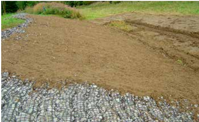
Abbildung 6.3.2 Nach dem Einbau erfolgt eine Übererdung und Einsaat (Steinmatratzen).
