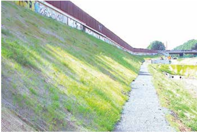
Abbildung 6.1.1 Böschungssicherung mit Erosionsschuttmatten.
