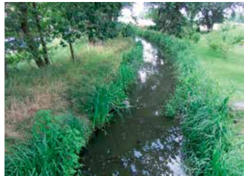
Abbildung 4.3.13: Die Vegetation hat sich gut entwickelt (Xylitwalzen und Röhrichtmatten).
