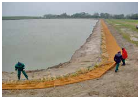
Abbildung 5.4.3.8: Übererdete Steinmatratzen mit darüber verlegten Röhrichtmatten
