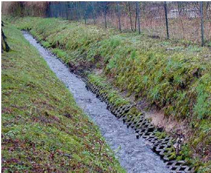
Abbildung 4.3.1 Zur „kanalisierten Abwasserrinne“ ausgebauter Bach.
