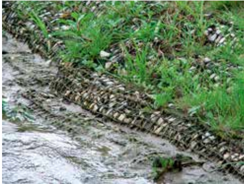
Abbildung 7.3.4: Uferbefestigung mit Steinmatratzen an einer Gefällestrecke.
