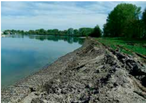
Abbildung 5.4.3.11: Schottermatratzen an einer Kiesgrube mit Wasserskibetrieb.
