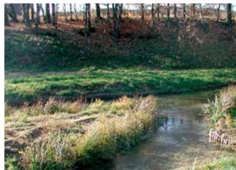
Abbildung 4.0.5: Die Abschnitte mit Kokoswalzen sind mangelhaft begrünt, eine zielgerichtete Bepflanzung ist sinnvoll.
