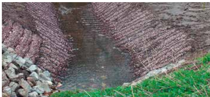
Abbildung 4.4.3.19 Das gesamte Gewässerbett wird mit Steinmatratzen (mit Schotterfüllung) ausgekleidet.
