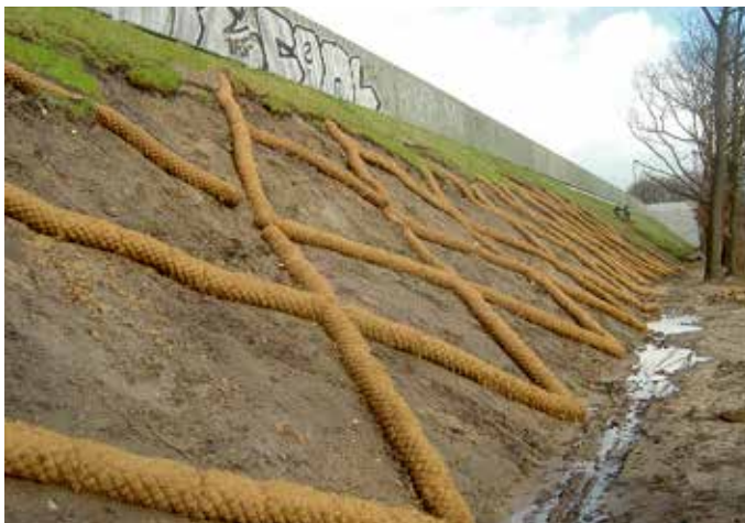
Abbildung 6.1.2.1 Böschungssicherung unterhalb einer Lärmschutzmauer (Kokoswalzen).
