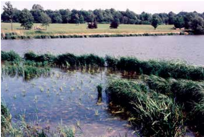
Abbildung 2.2.1 Pflanzung von Röhricht- matten (rechts und oben) und Topfballen. Für die Topfballen war die Pflanz- tiefe von 20 cm schon selektiv.
