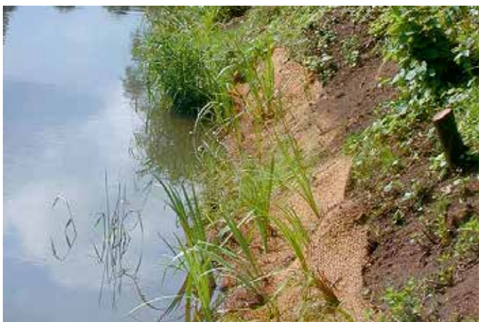
Abbildung 4.1.3.2 Sicherung eines Ufers mit Kokosgewebe und Einzel- pflanzen (auch als „Röhrichtgewebe“ bezeichnet).
