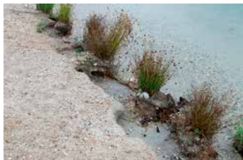
Abbildung 5.0.4: Typische Erosionserscheinungen an einem neu gestalteten Uferbereich. Hier mit ungeeigneter Pflanzenauswahl: Juncus effusus wächst horstartig und entwickelt keine flächige Abdeckung des Uferbereichs.
