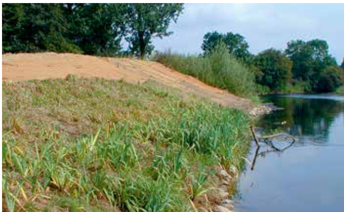
Abbildung 4.2.6 Flächige Sicherung einer von Hochwasser belasteten Böschung unmittelbar nach der Baumaßnahme (Röhrichtmatten und Kokosgewebe).
