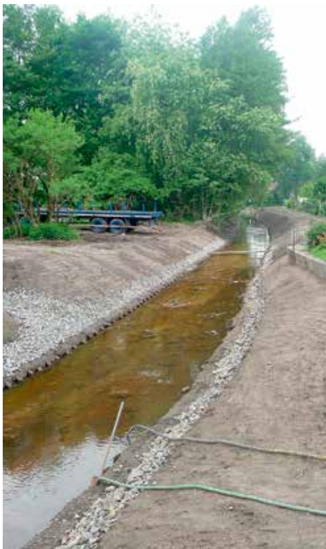
Abbildungen 4.3.19 und 4.3.20 Böschungssicherung eines Baches unmittelbar nach Einbau und ca. zwei Jahre später (Steinwalzen und Bepflanzung mit Einzelpflanzen)
