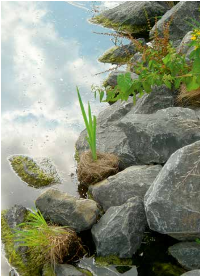
Abbildung 4.4.1.1 Einzelpflanzen in Deckwerken fehlt durchwurzelbares Substrat.
