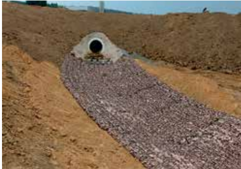
Abbildung 6.2.2.2: Auslauf eines Regenwasser-sammlers (Steinmatratzen).
