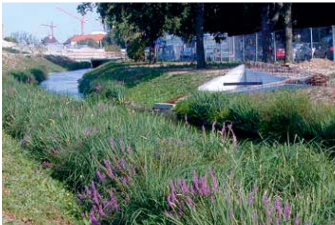
Abbildung 4.2.1 Ansiedlung eines bach- begleitenden Röhrchits mit gleichzeitiger Ufersicherung mittels Röhrchtmatten.
