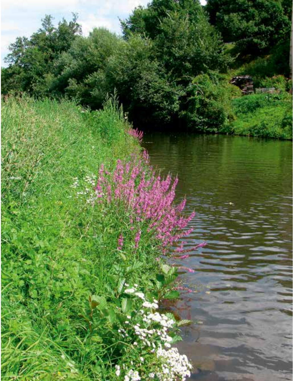
Abbildung 5.4.3.14: Böschungssicherung mit Steinmatratzen an einem Altarm. Die technische Sicherung ist nach zwei Jahren gänzlich unter dem dichten Bewuchs an der Uferböschung verschwunden.
