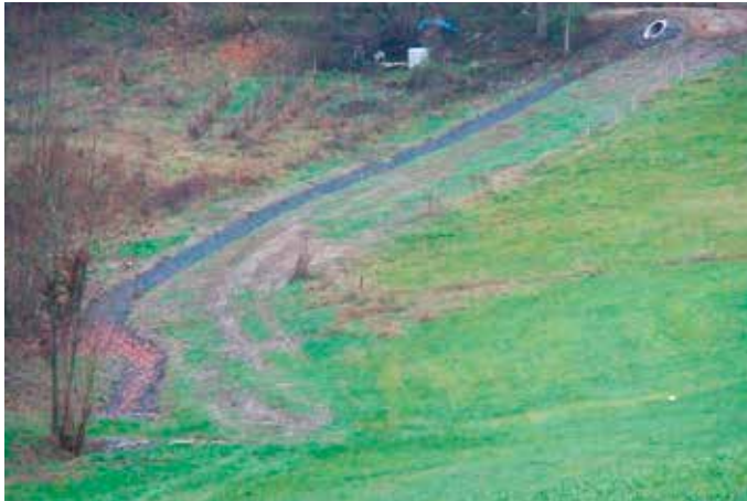
Abbildung 6.2.2.1 Ein typisches Beispiel einer Entwässerungsmulde an einem Berghang (Steinmatratze).
