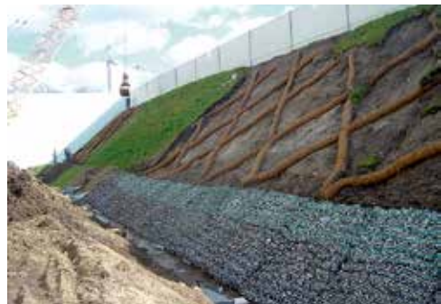
Abbildung 6.1.2.3: Böschungssicherung oberhalb der Steinmatratzen (Steinmatratzen und Kokoswalzen).
