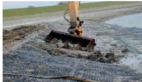
Abbildung 5.4.2.3: Die Flussmatratzen werden eingeschlämmt.
