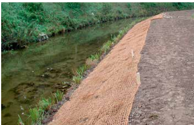
Abbildung 4.0.1 Fließgewässer unmittelbar nach einer Hochwasser- schadensbeseitigung (Röhrichtwalzen und Kokosgewebe).
