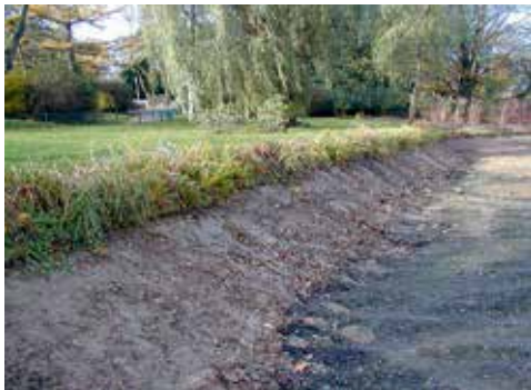
Abbildung 5.2.3.5: Einbau von Röhrichtmatten im Herbst bei abgesenktem Wasserstand.
