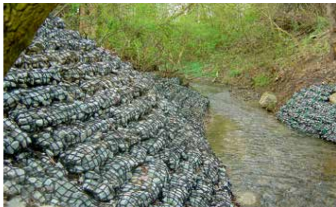
Abbildung 4.4.3.1 Steinmatratzen als Böschungssicherung an einer steilen und hohen Uferböschung.
