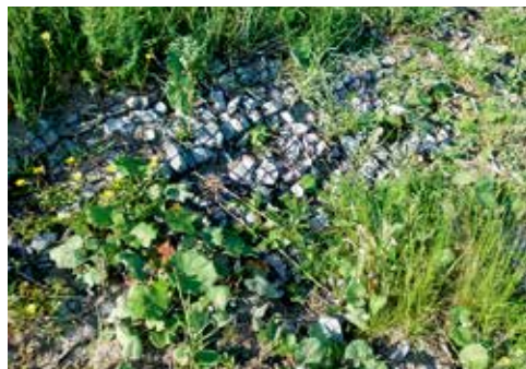
Abbildung 5.4.3.10: Pionierpflanzen breiten sich in den Steinmatratzen aus.
