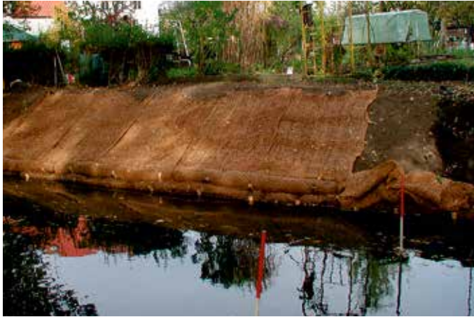
Abbildung 4.1.3.1 Eine relativ steile Böschung wird mit Kokoswalzen und Kokosgewebe gesichert.
