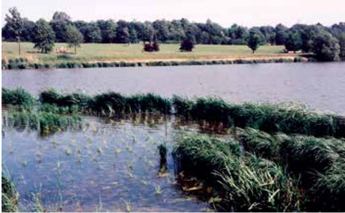
Abbildung 5.2.1.1 Anlage einer Berme. Zum See hin wurden Röhrichtmatten zum Dämpfen der Wellen verwendet. Der Flachwasser- bereich im Vordergrund wurde mit einem Kokosgewe- be gesichert. Durch dessen Maschen sind die Röhricht- Topfballen gesetzt worden.
