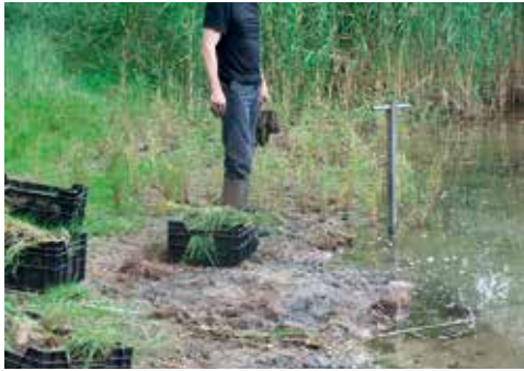
Abbildung 5.1.2.2: Setzen von Schilfbällen 5 × 12 cm mit Hilfe eines Pflanzdorns.
