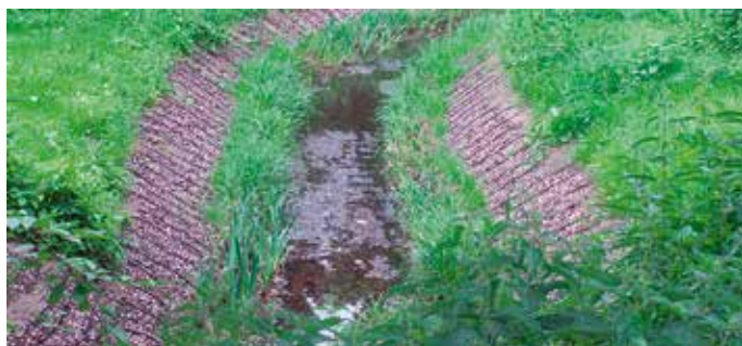
Abbildung 4.4.3.20 In diesem Fall wurde die Mittelwasserlinie zielgerichtet mit einer Röhrichtmatte (0,5 m breit) bepflanzt.
