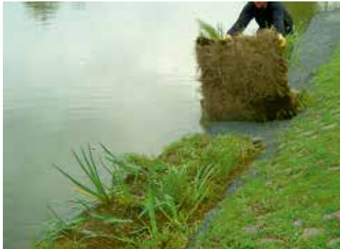
Abbildung 5.2.3.3: Röhrichtmatten werden an der Wasserlinie verlegt.
