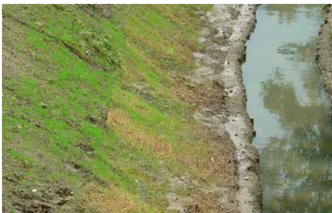
Abbildung 4.1.1 Bach mit Kokoswalzen (Durchmesser 20 cm) als Böschungsfußsicherung.
