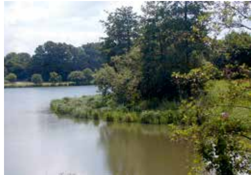
Abbildung 2.1.3: Vorschüttung zur Schaffung einer Flachwasserzone. Sofortige Abdeckung und Bepflanzung mit Röhrichtmatten.
