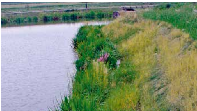
Abbildung 5.0.2 Röhrichtpflanzung mit Röhrichtmatten an einem Sandentnahmesees.
