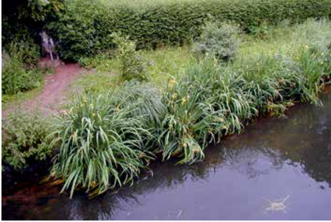
Abbildung 4.2.3 Böschungfußsicherung und -begrünung an einem innerörtlichen Bachlauf (Kokoswalzen und Röhricht- matten zur schnellen Besiedlung).
