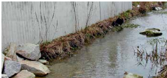
Abbildung 4.3.9 Kaschierung einer Beton- mauer nach Einbau im Winter (Röhrichtwalze).
