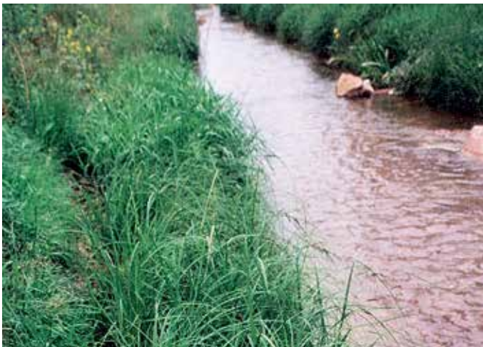
Abbildung 4.2.11 Röhrichtmatte als Ufersicherung an einem Bach mit kurzfristig stark schwankenden Abflussmengen.
