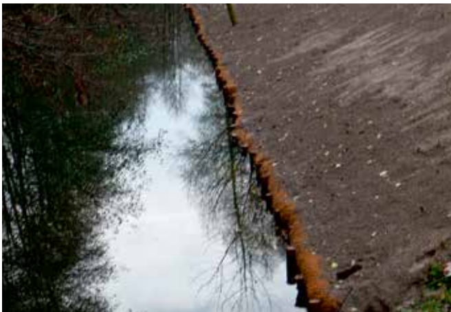
Abbildung 4.2.4 Eine instand gesetzte Böschung an einem Ablaufgraben (Kokoswalzen).
