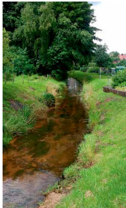
Abbildungen 4.3.19 und 4.3.20 Böschungssicherung eines Baches unmittelbar nach Einbau und ca. zwei Jahre später (Steinwalzen und Bepflanzung mit Einzelpflanzen)
