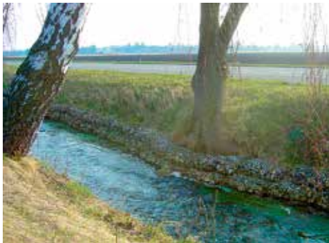
Abbildung 3.9.1: Steinwalzen als Böschungsfußsicherung an einem unterschrittenen Straßendamm.
