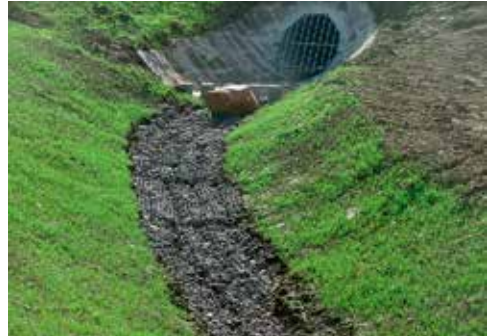
Abbildung 6.2.2.3: Nach der Fertigstellung wurde der Oberboden teilweise wieder abgetragen (Steinmatratzen).
