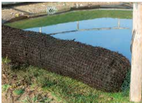
Abbildung 3.7.4: Xylitwalze mit 30 cm Durchmesser vor dem Einbau.
