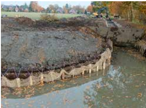
Abbildung 4.3.12: Baustelle unmittelbar nach dem Einbau der Xylitwalzen
